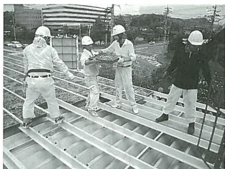
折板屋根の緑化工事
