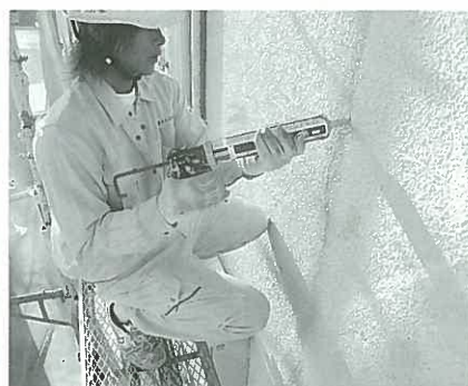
マンションの外壁工事
