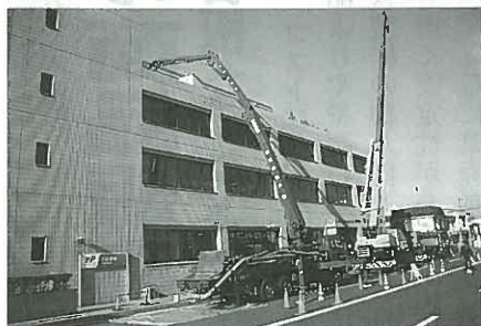
福山東郵便局の工事
